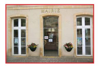
La porte principale de la mairie a dû être condamnée pour des raisons de sécurité, les charnières pivots sont usées et risquent de casser. De plus, cette porte en simple vitrage est une source importante de déperditions thermiques et n'est pas étanche à l'air. Le dossier de déclaration de travaux est à l'instruction auprès des différents services de l'urbanisme.
