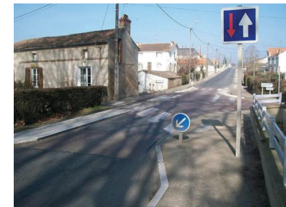
Rétrecissement de chaussée bidirectionnelle Limiter le croisement entre les deux véhicules pour réduire la vitesse
