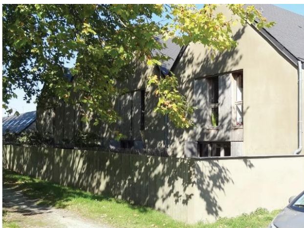
Mur de clôture en limite d'opération
